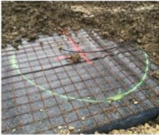
Treillis d'ancrage de la motte
